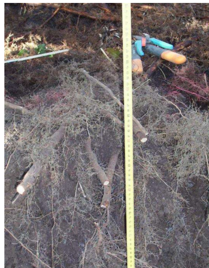
Figur 17 och 18 Rötter som friläggs ska alltid hållas fuktiga, om återfyllning inte sker inom 1 timma ska ändamålsenligt rotdraperi användas. Rötter mellan 20-50 mm som måste kapas ska klippas eller sågas med rena snitt.
