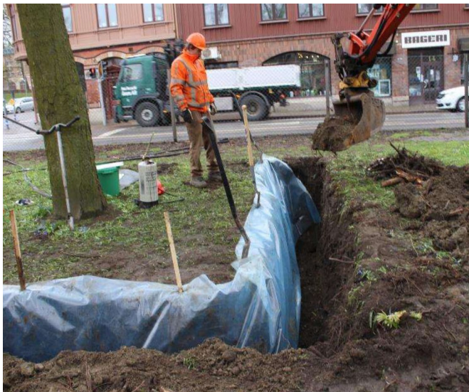
Figur 17 och 18 Rötter som friläggs ska alltid hållas fuktiga, om återfyllning inte sker inom 1 timma ska ändamålsenligt rotdraperi användas. Rötter mellan 20-50 mm som måste kapas ska klippas eller sågas med rena snitt.
